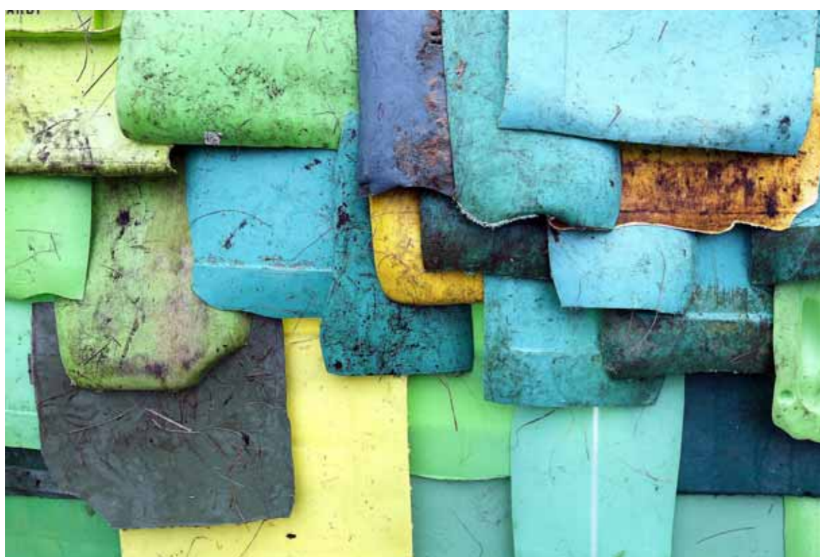
Veggen er kledd med grønn plast, med gule og blå innslag: Håpet er lysegrønt, var hyttas arbeidstittel.
